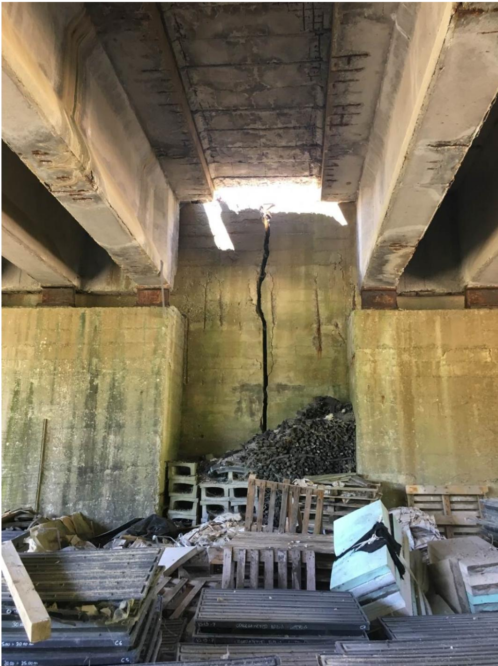
Figura 25 – Foto spalla viadotto
