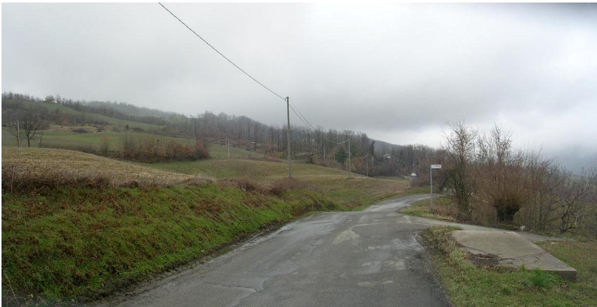
Figura 84 – Tratto interessato dall'intervento – vista panoramica da monte
