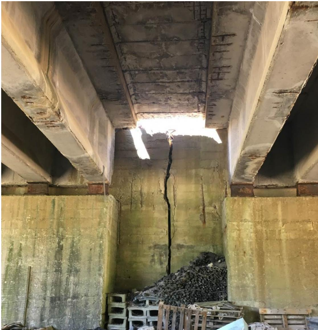
Figura 28 – Foto spalla viadotto
